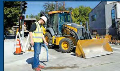
**Rušení/interference** je elektrické rušení, které může ovlivnit přesnost lokátoru, obvykle je způsobeno rozvodnami nebo podzemními i nadzemními kably vysokého napětí
