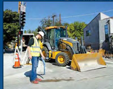
**干扰**是指可能会影响管线仪精度的电气干扰，通常是由变电站以及埋地或架空高压电缆引起的。
