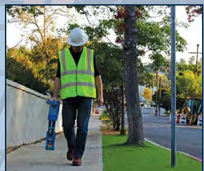
带有阴极保护系统的管道可以使用 CPS 被动模式进行跟踪。CPS 罗盘模式可确保与目标管道对齐。
