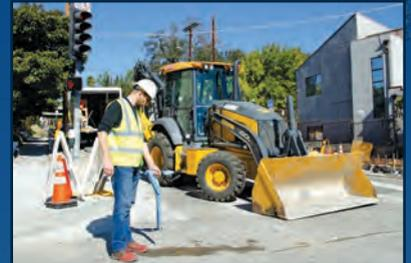
Les interférences sont des perturbations électriques qui peuvent influencer la précision du détecteur, généralement provoquées par des postes de distribution ou des câbles haute tension enterrés ou aériens
